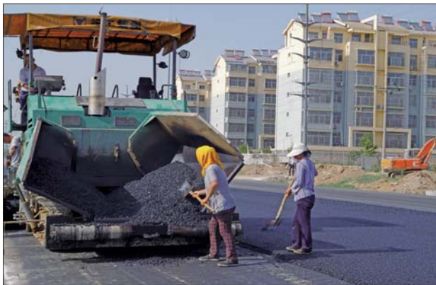
正在施工的澄波湖路。 本报记者 梁越 摄
