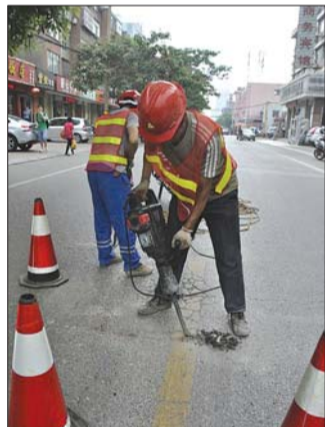
工人正在紧张修复康复路。本报记者 赵兴超 摄
