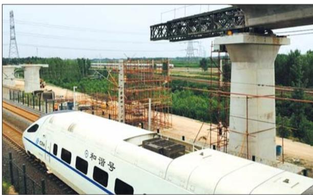
备受关注的石济客专建设再次传来捷报, 24日下午5时, 经过11天的不懈顶推, 由中铁十局承建的石济客专五里堂特大桥116米连续箱梁成功横跨过胶济客专, 为五里堂特大桥实现贯通奠定了基础, 标志着石济客专一项关键控制性工程成功攻破。
