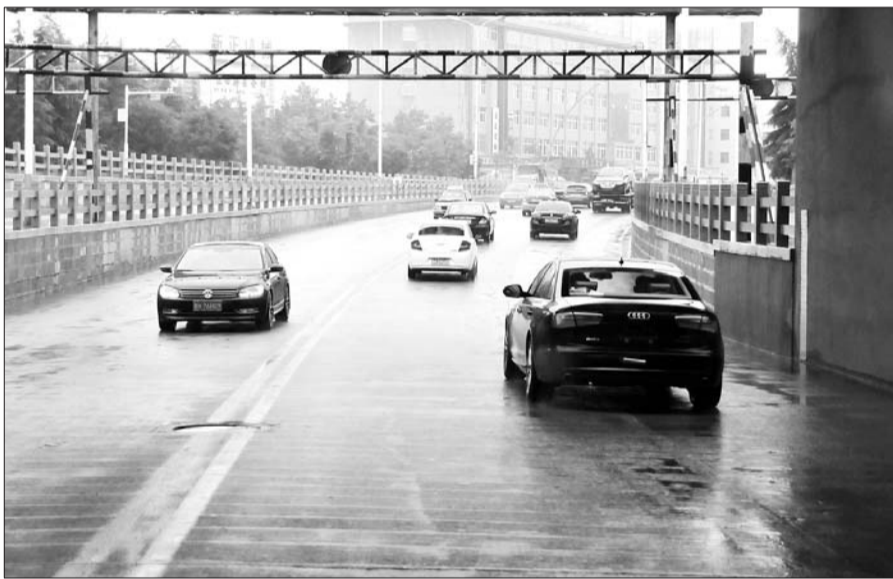
火炬路高铁立交桥下没有积水。本报记者 李岩松 摄
