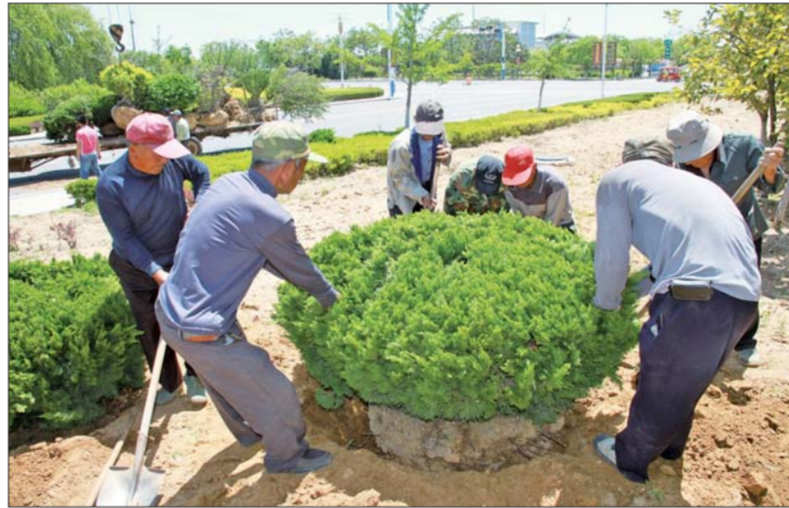
▲工作人员在乳山银滩道路两侧进行管道铺设后的植被复植。
