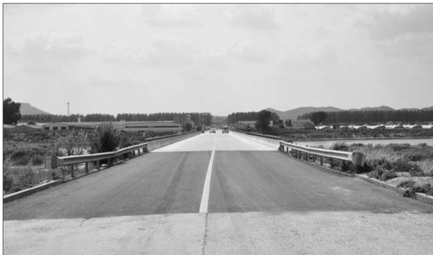
林西线夹河大桥 大修完工通车
