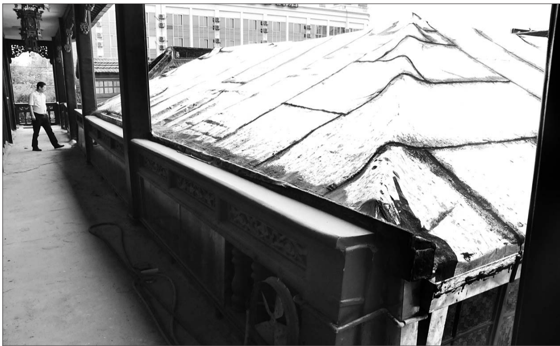
►潘家大楼的屋顶已经完成整修。本报记者 张晓科 摄
