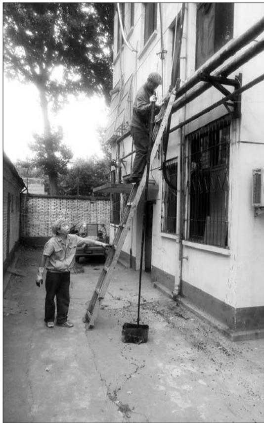
工作人员正在修补供暖管道的保温层。本报记者 康宇 摄
