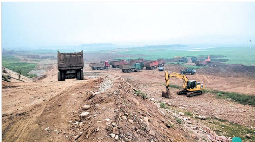
16日上午,在卧虎山水库北岸,大量施工机械正在扩挖水库。 本报记者 蒋龙龙 摄
