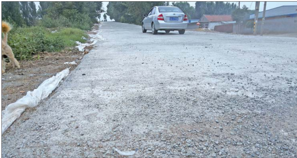
西关大堰目前仅铺设了一层水泥沙浆。
