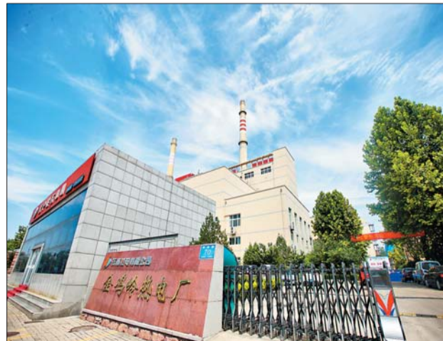
济南热电有限公司金鸡岭热电厂全景。
