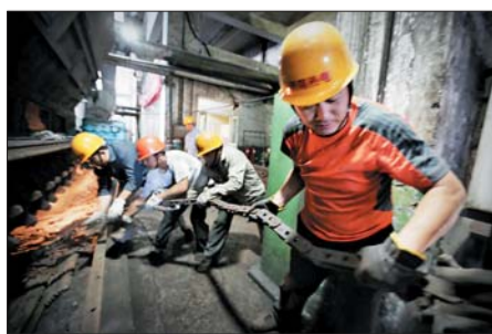
▲炎炎夏日,热电职工在检修锅炉。
