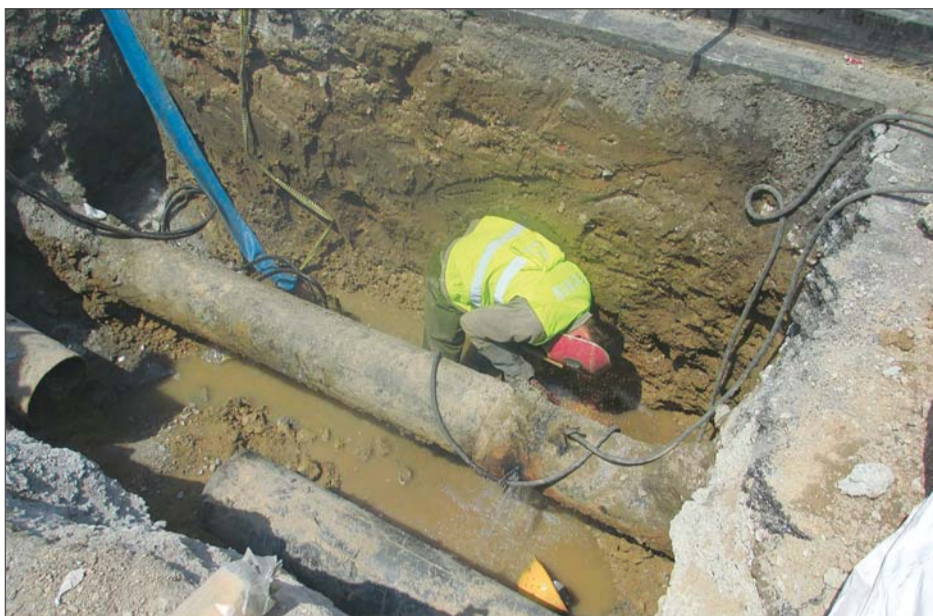
水务集团正在对一处管道进行合口。(资料片) 本报记者 蒋龙龙 摄
