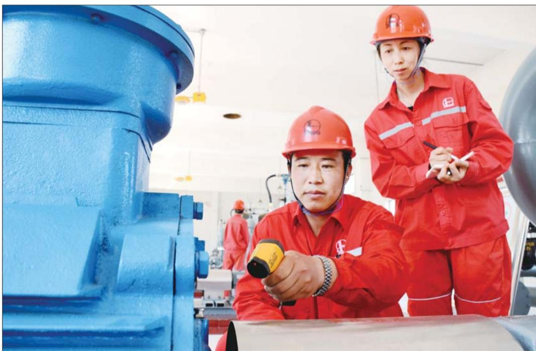
胜利油田现河史127采油管理区员工正在检测脱水泵电机轴承温度。 通讯员 孔明磊 摄
