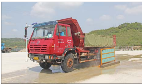
烟台首座建筑垃圾处置场启用,图为运输车出场前清洗。
