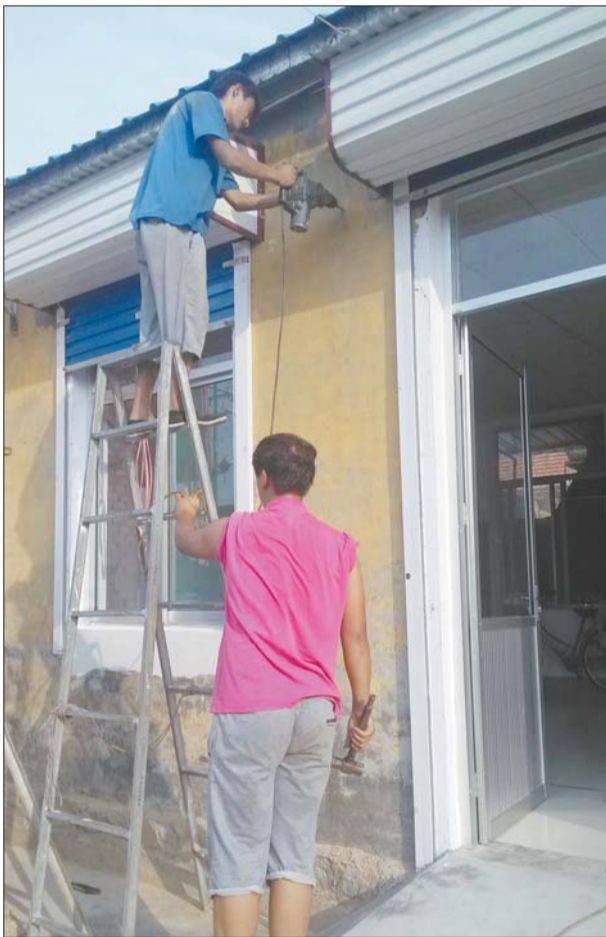
陈龙踩在梯子上,拿着电钻往墙上打孔。
