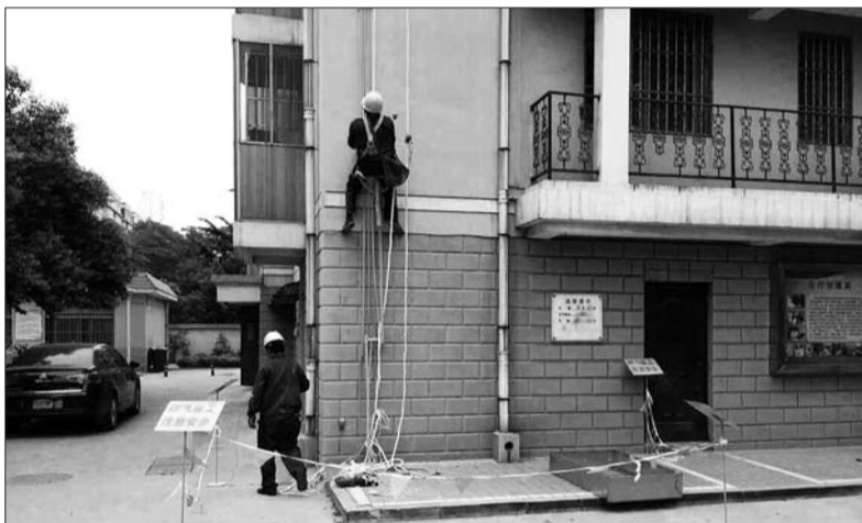
▶ 燃气安装人员正在铺设新的燃气管道。本报记者 康宇 摄
