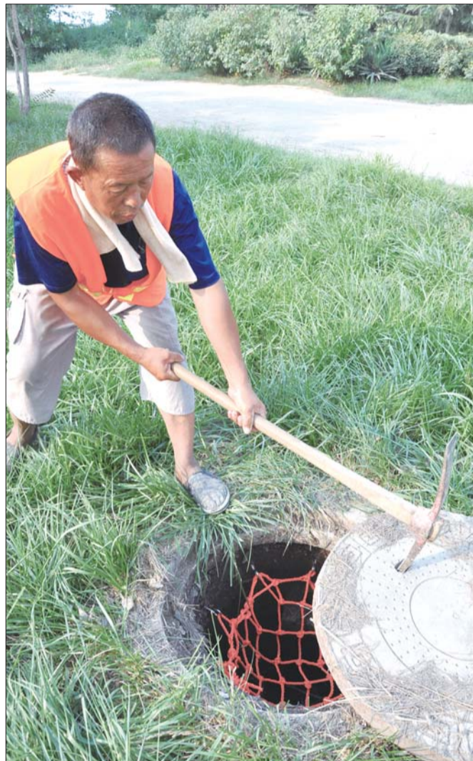
装好防坠网,施工人员盖上井盖。本报记者 公素云 摄
