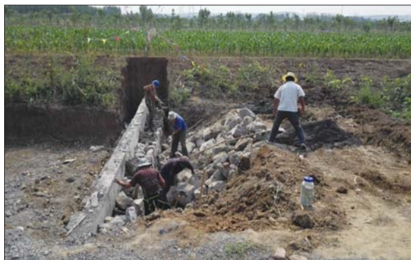
淄博已进入汛期, 涝淄河综合整治工程正在施工。
