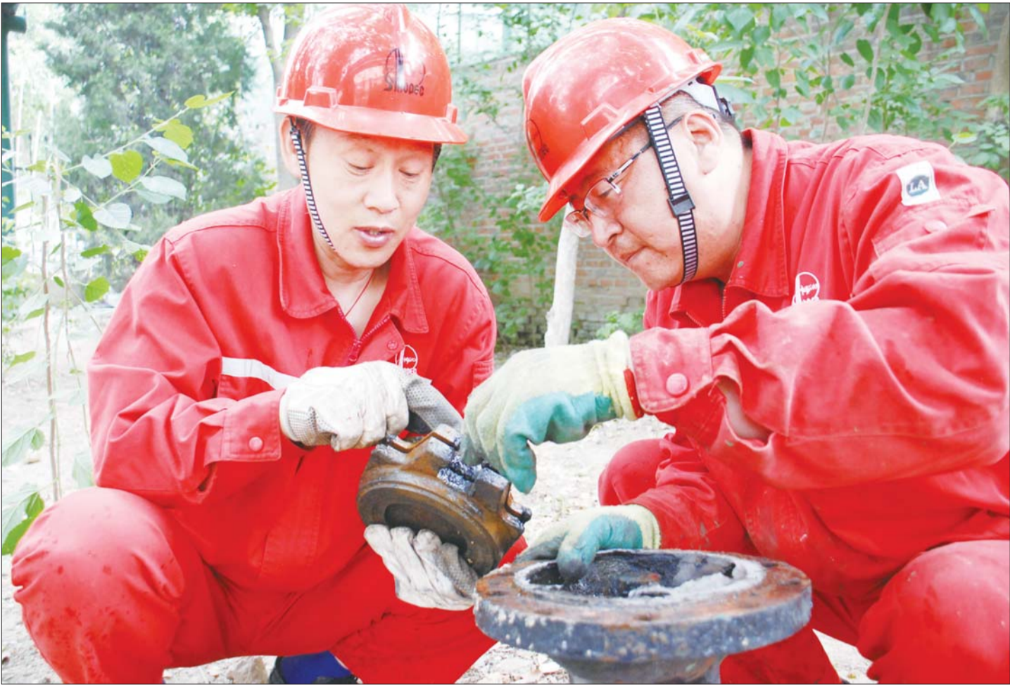
胜北热力大队的工作人员正在对阀门进行解体、检修。
