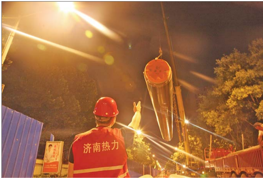
为了维护交通,一些管网安装工作只能在夜间进行,目前主管网已经敷设完成。
