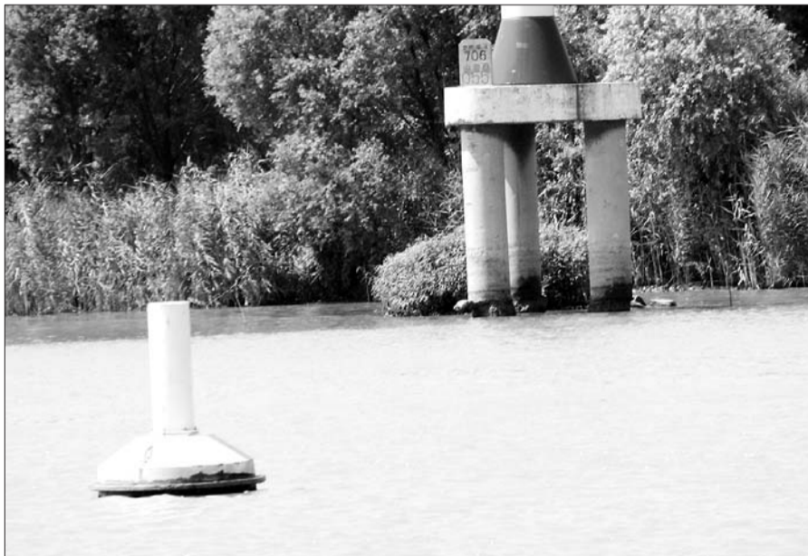
湖至微山岛航道交叉河口右岸的7号航标底部快要露出地面。
