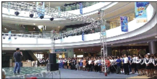
“电梯突然出现故障不能动,要紧急按下红色按钮……”对正在维修的电梯,要设置好安全围栏
