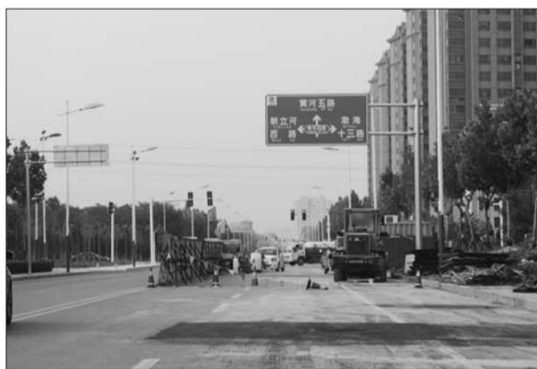
29日白天,新立河东路上的最后一处污水干管治理围挡。
