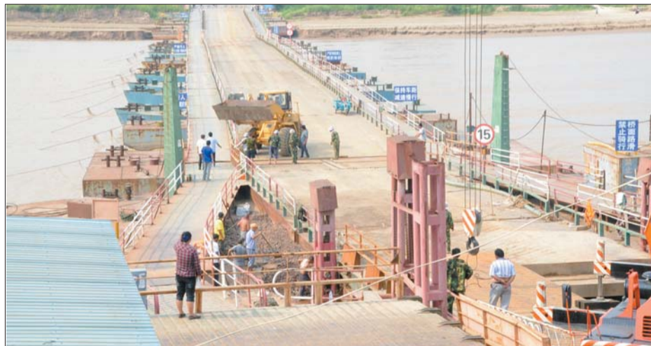
2日15时30分左右，工作人员在高温天气中抢修浮桥。
