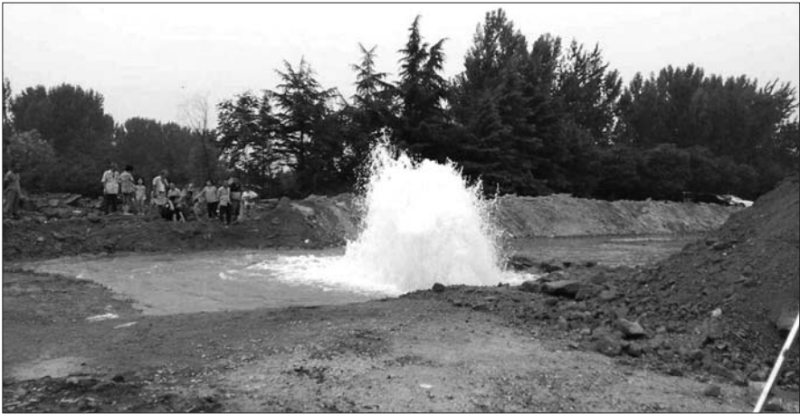
自来水管被挖断后,水蹿出2米多高。(市民供图)
