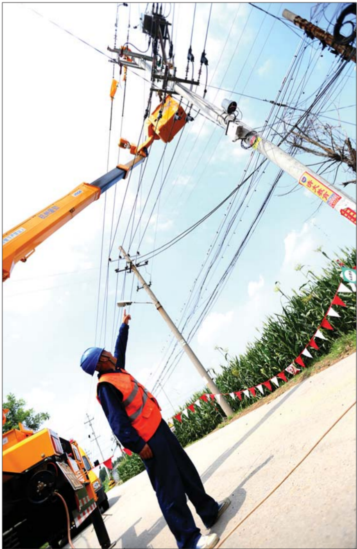
拥有20多年抢修经验的张致刚在指挥孙家鹏维修供电线路。
