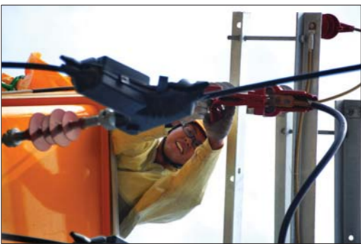
孙家鹏抢修供电线路。
