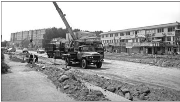
13日下午,正在施工的荷花路东段。
