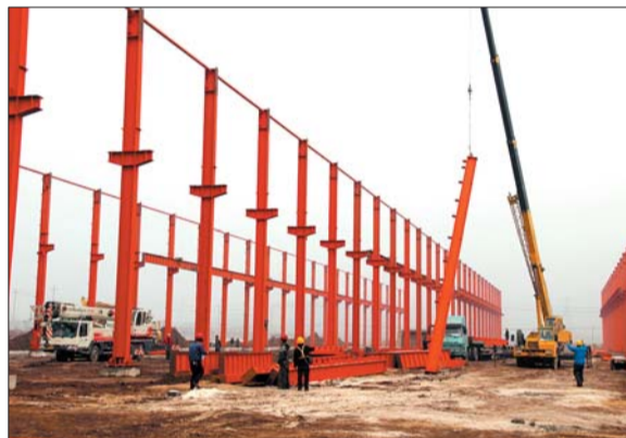
汇富建筑产业化生产研发基地即将投产。(资料片)
