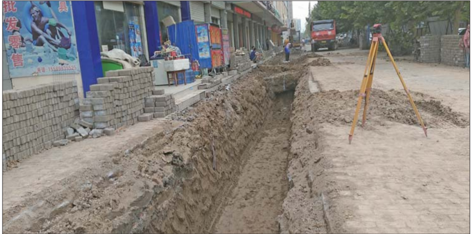
永安路雨污管道改造现场。 本报记者 梁越 摄
