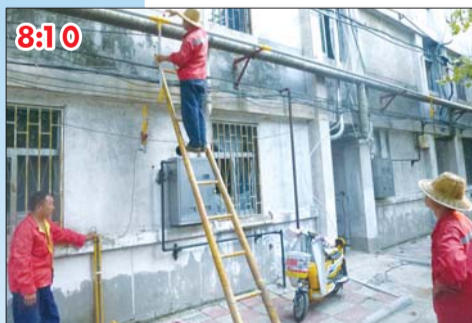
8:10 工人们前一天焊接的架空管道做气密性试验。
