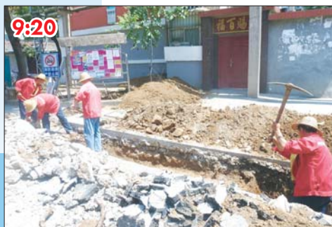
9:20 气温已经升高，工人们正在开挖管沟。
