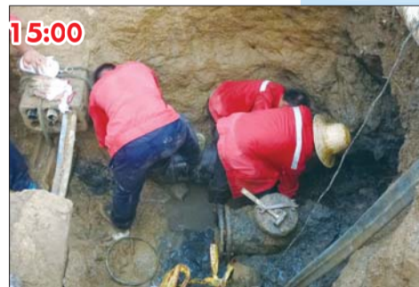
15:00 工人盛健(左)和同事在连接管道支管。
