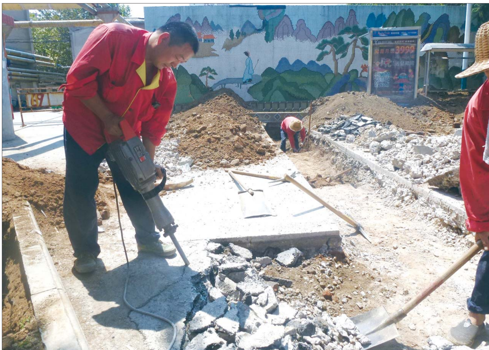
徐利用电镐破拆厚厚的水泥路面
