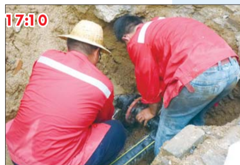
17:10 工人们在污水工作坑内清理淤泥，连接主管道。
