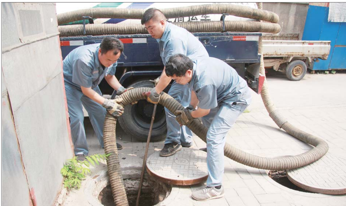
城肥二处工作人员正在用清运车抽取化粪池内的便便。 本报记者 王小蒙 摄
