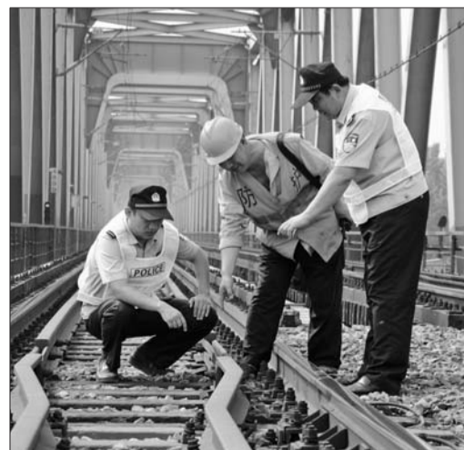
抗日战争暨反法西斯胜利70周年到来之际,济南铁路公安处台前所民警对黄河特大桥进行全面安全检查。(刘辉 摄)
