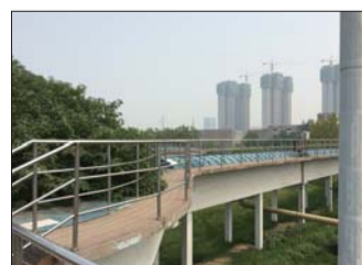
光大水务(淄博)有限公司污水处理过程实现全封闭。 本报记者 刘晓 摄
