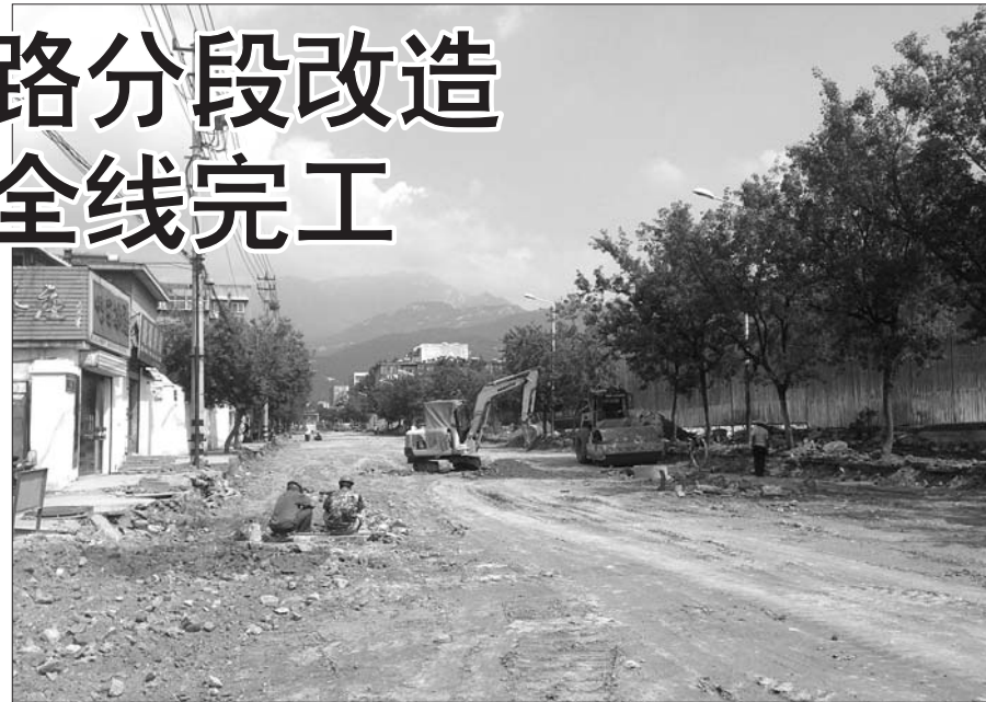
傲徕峰路南段已开挖土方。本报记者 王世腾 摄
