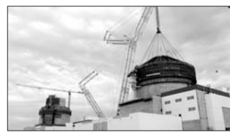
海阳核电2号机组穹顶就位。 通讯员 姜涛 摄
