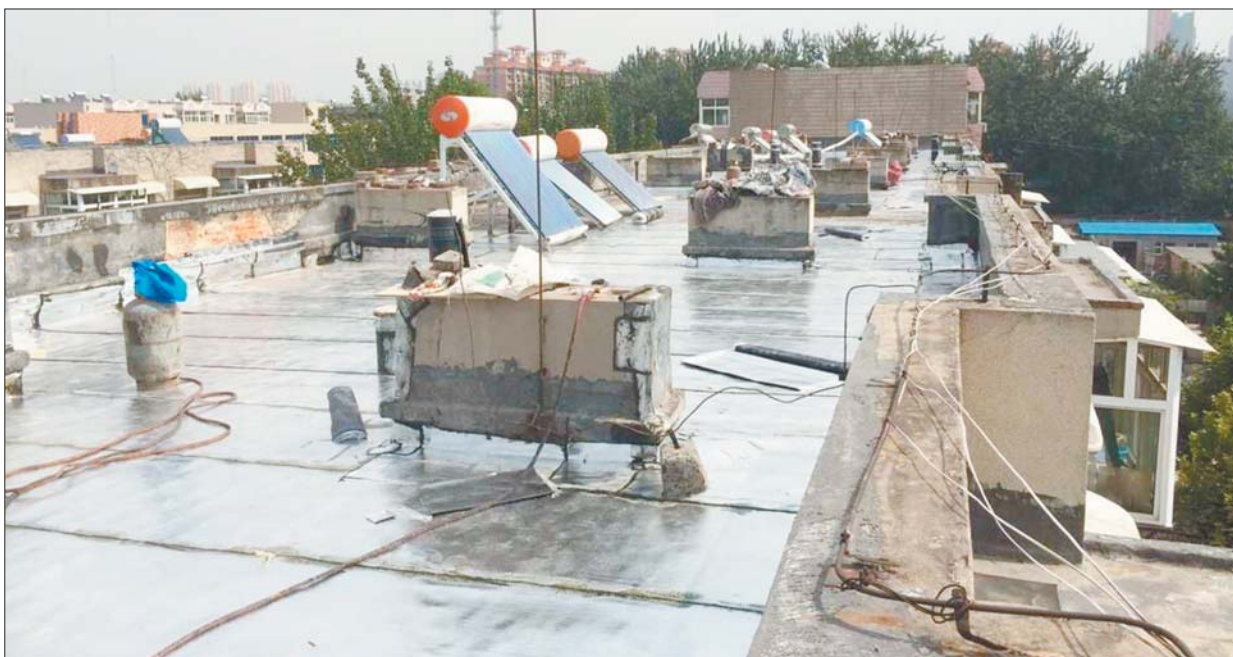
济南化纤小区维修资金被激活，楼顶正在维修，业主再也不用担心雨天漏雨了。
