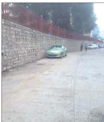
地锁拆除前后对比(拆除后)
