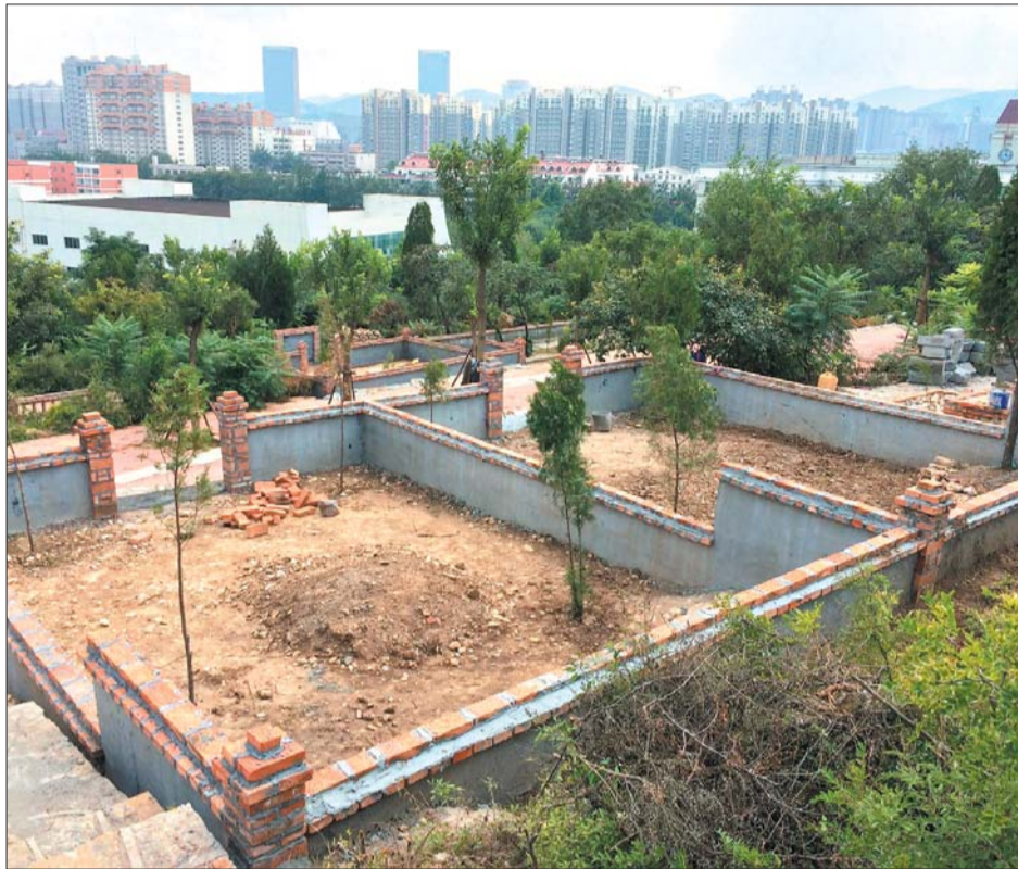
正在建造的墓穴,每座面积都有三四十平方米。
