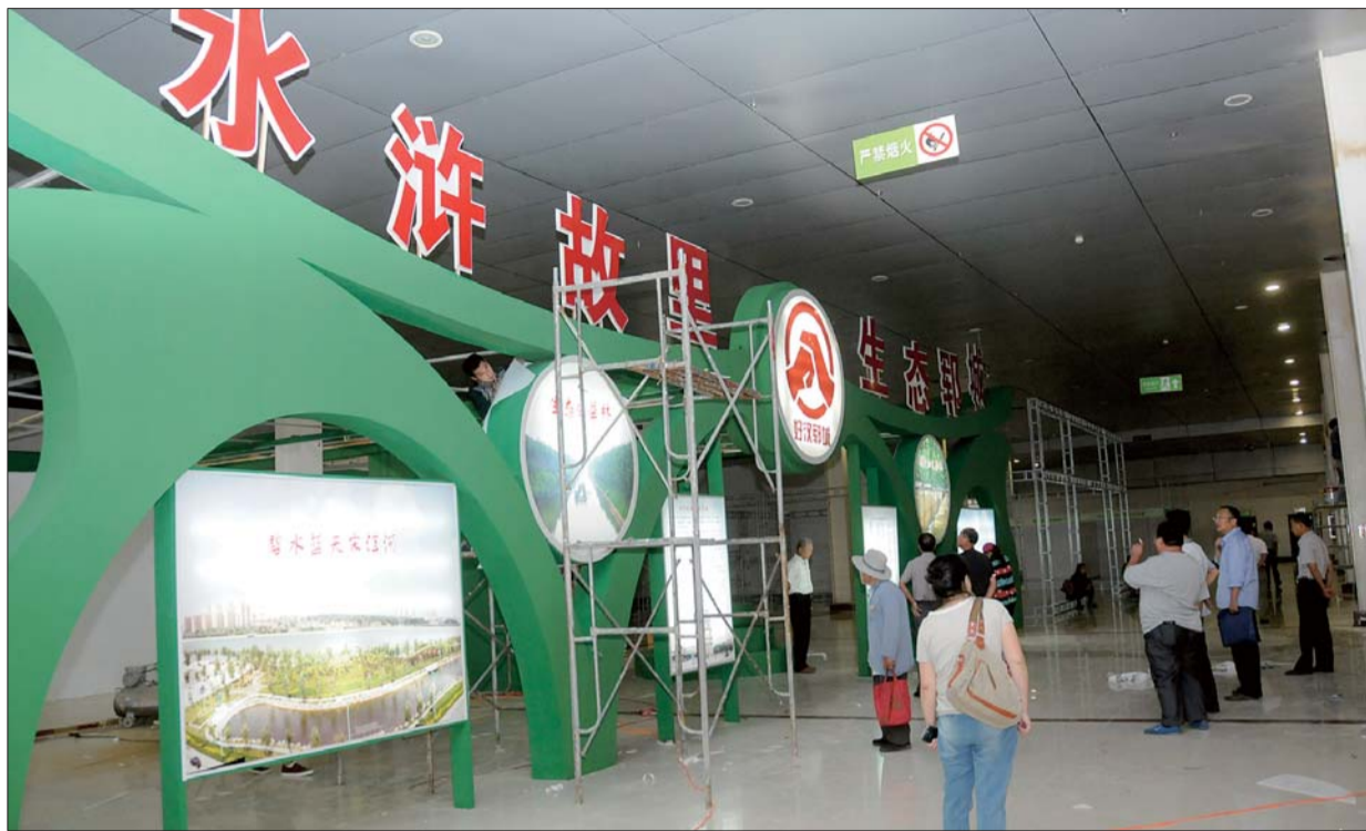
17日,记者在中国林展馆看到,各展厅都在装修布展中,部分商家也陆续将展品运输至此。 本报记者 邓兴宇 摄
