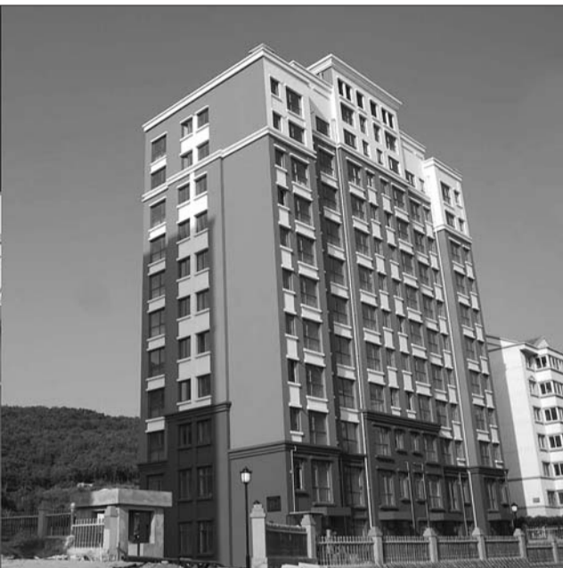
公租房楼体外景,和部分内部实景图。记者 王震 摄
