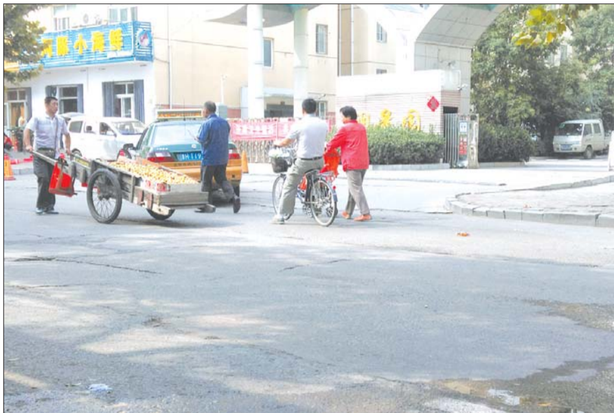
门前道路坑洼不平。本报记者 孟杰 摄
