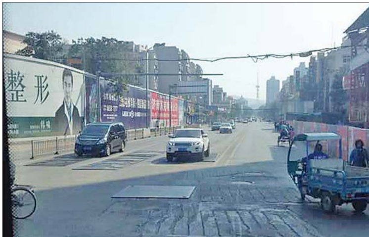
◀泺文路地下人防仍在施工。
