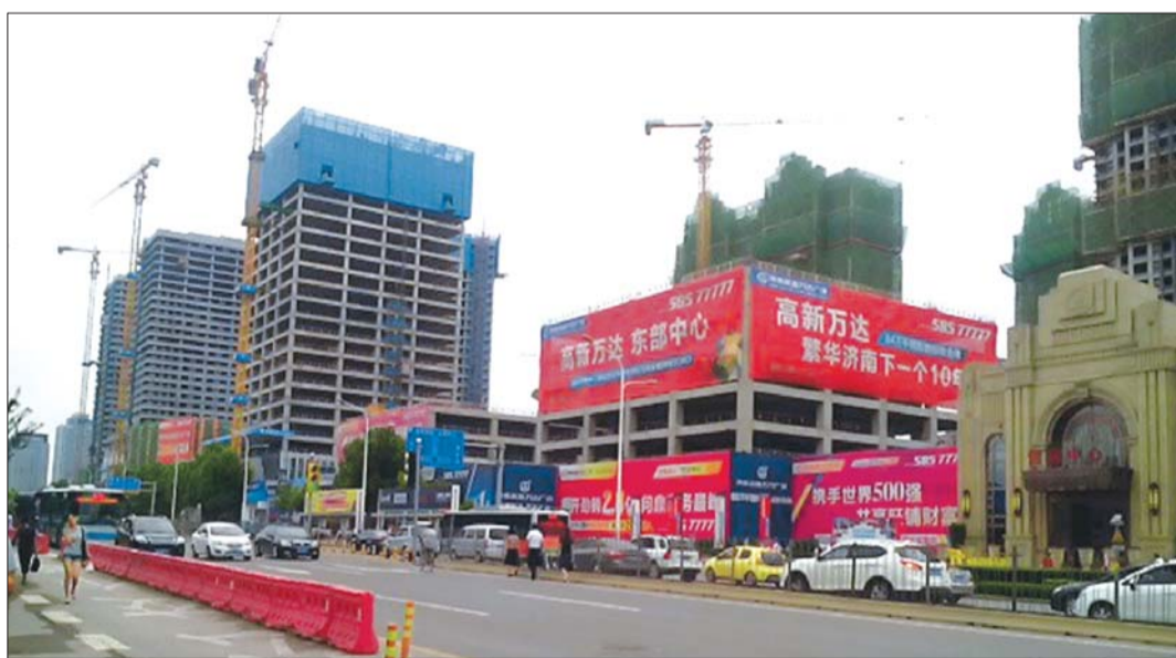
正在建设中的高新万达项目
