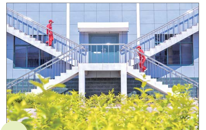
员工进行工艺巡检。
