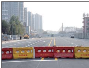
中华路段还在施工中。
