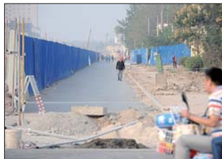
慢车道和人行道还需施工。
