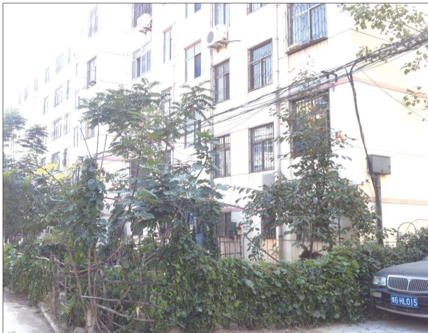
新时代小区入住多年供暖管道已经老化严重。 本报记者 张召旭 摄
