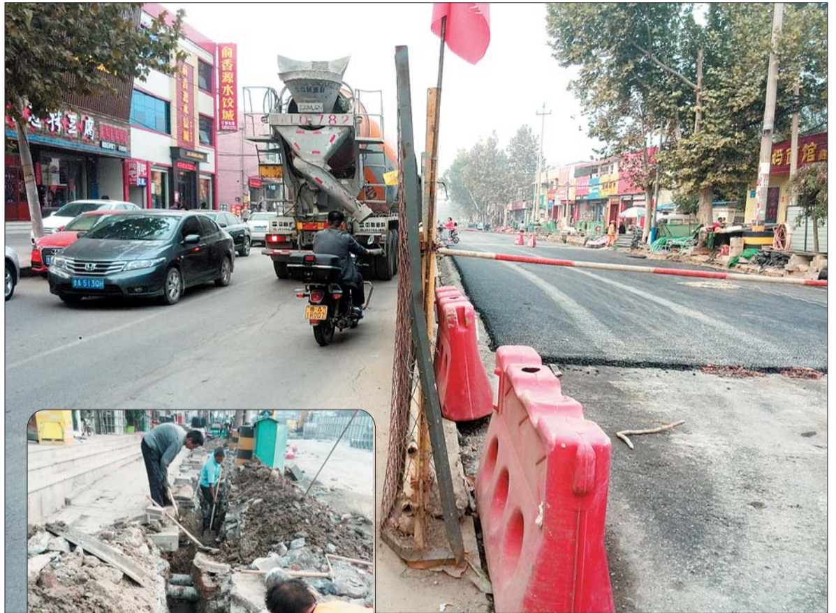
▲化纤厂路东侧正在铺沥青。
