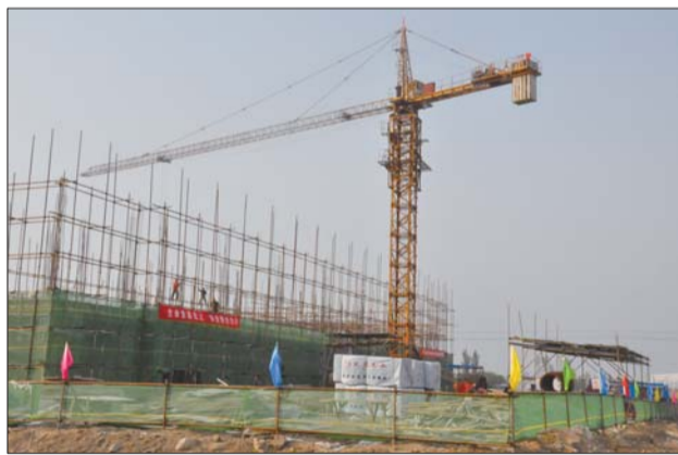
定陶大项目建设现场。
