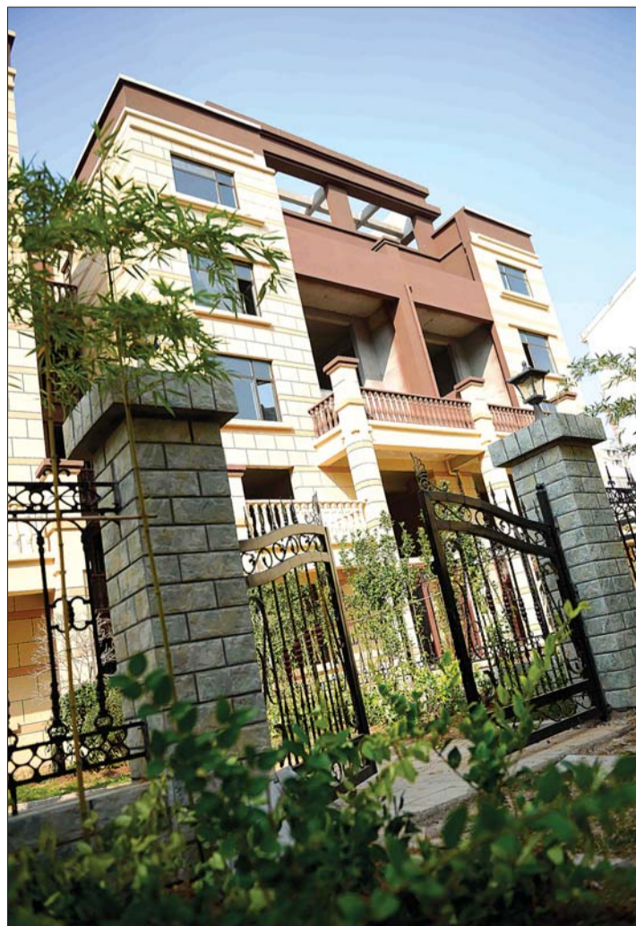
小区外墙和大门已经装饰完毕。
